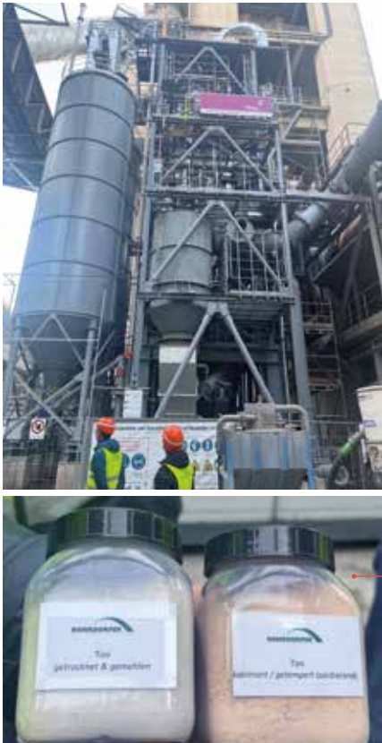
Mit der Pilotanlage für die Herstellung von getempertem Ton können täglich rund 50 Tonnen des CO 2 -ärmeren Materials hergestellt werden. Mit einer sogenannten „Color Control Unit“ wird aus dem etwas rötlichen Material wieder „graues Material“.
